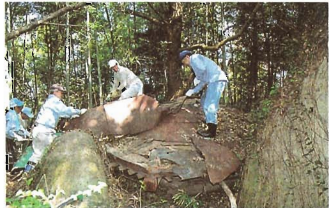
昭和25(1950)年に建てられた展望所を解体する参加者
